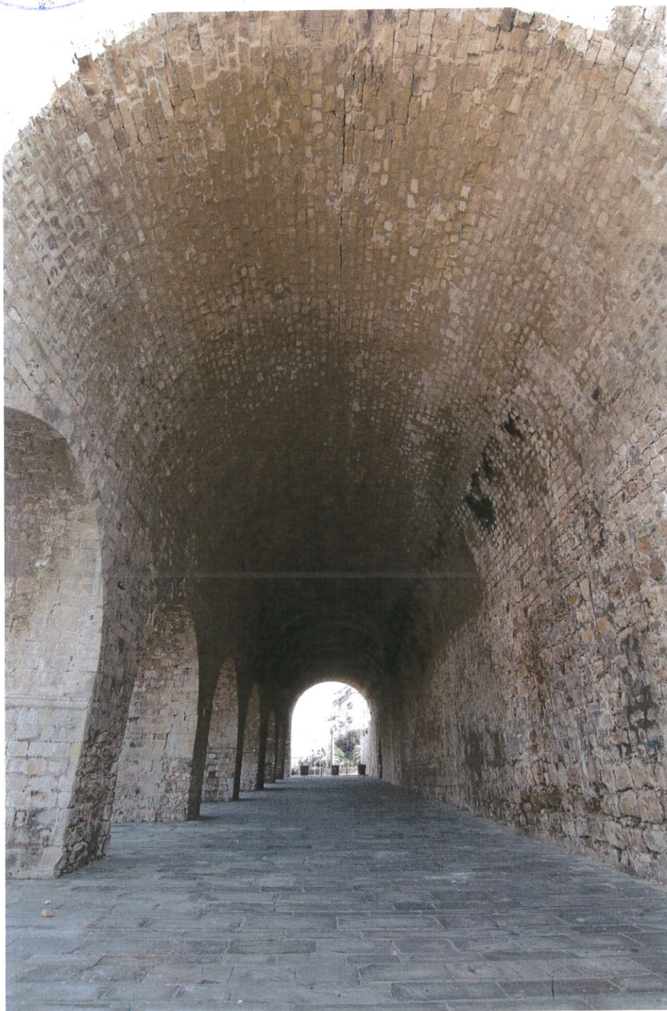
Το εσωτερικό του ανατολικού νεωρίου. Άποψη προς τα ανατολικά.
