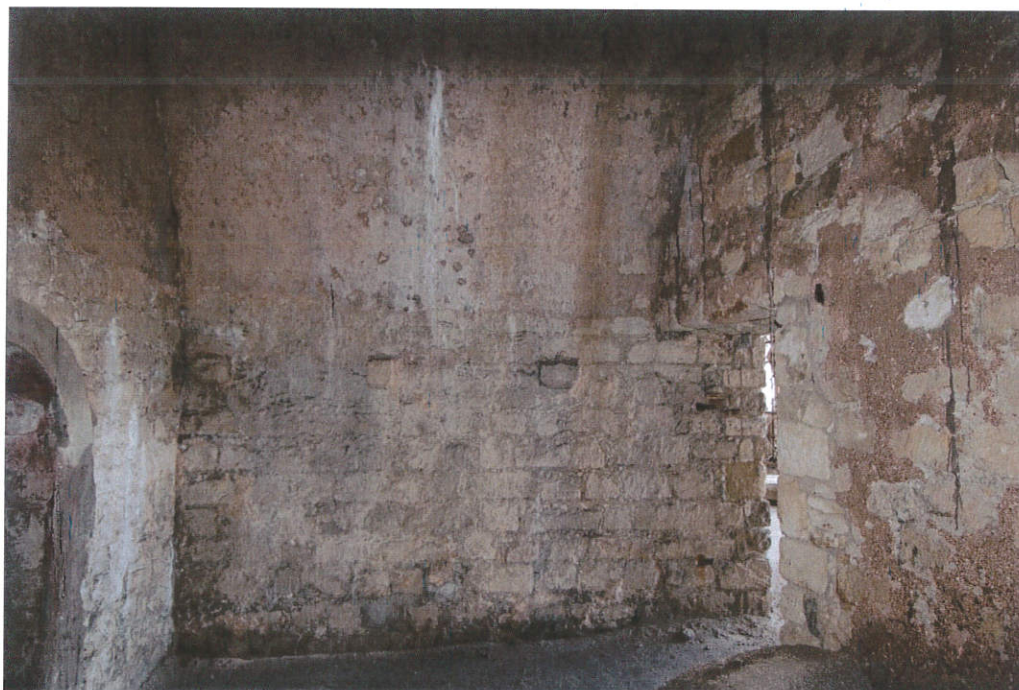
Το εσωτερικό της δεξαμενής του πρώτου νεωρίου
