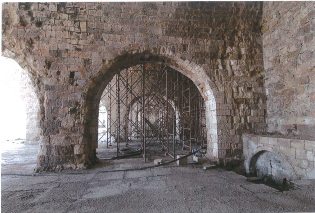
Το εσωτερικό του τετάρτου νεωρίου προς τα ανατολικά
