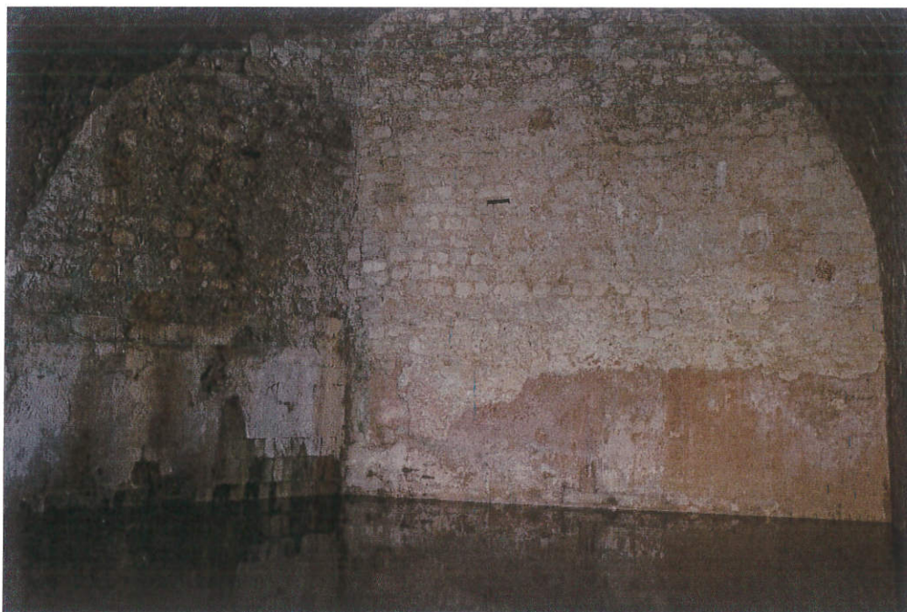
Ο δυτικός τοίχος του νότιου χώρου της δεξαμενής Ζάνε
