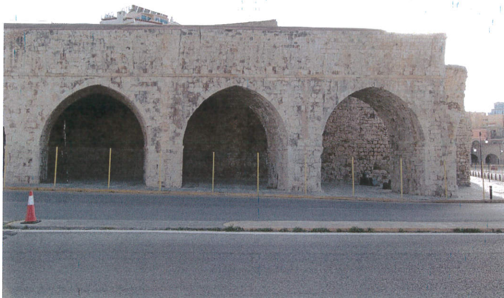
Το παλαιότερο τμήμα του ανατολικού νεωρίου, μέρος των Arsenali Nuovi
