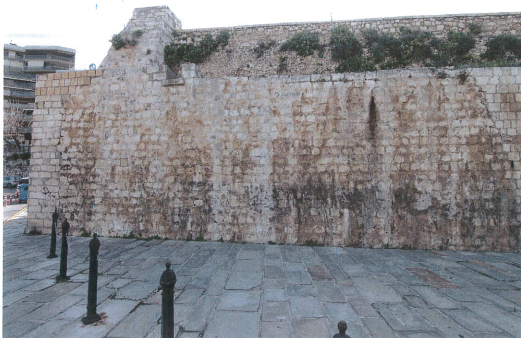
Ο βόρειος τοίχος της δεξαμενής Ζάνε
